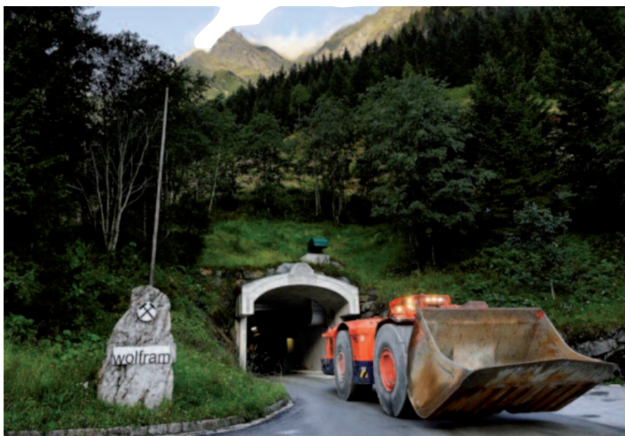
ENTRÉE DE LA MINE SOUTERRAINE DE MITTERSILL SITUÉE AU SEIN DU PARC NATIONAL DU HAUT TAUERN EN AUTRICHE
