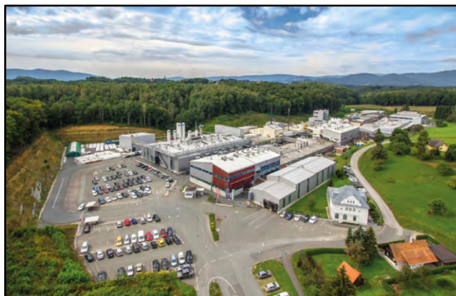
Usine métallurgique de St. Martin im Sulmtal (production d'APT, oxydes de tungstène, poudres de tungstène, carbures de tungstène)
