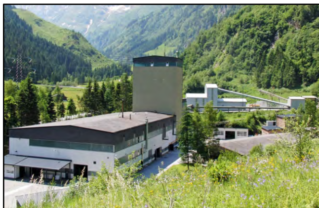
Usine de concentration du minerai à 3 km en aval de la mine
